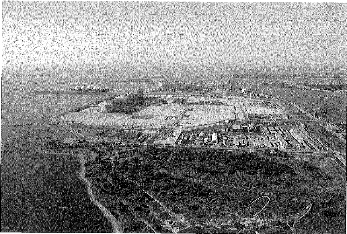
LE SITE DU TERMINAL METHANIER DE FOS-CAVAOU
